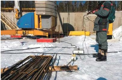
Георадиолокационные исследования востребованы на всех этапах жизненного цикла объектов капитального строительства: при выполнении проектно-изыскательских работ, строительства, эксплуатации объектов.
